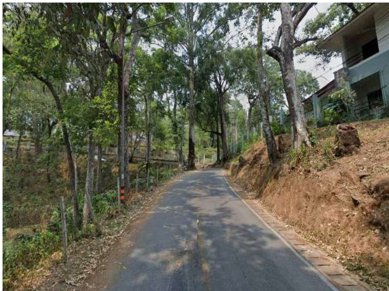
รูปที่ 5.1-4 สภาพพื้นที่ แนวทางหลวงหมายเลข 1004 (ช่วงที่ 4 กม.18+627 - 19+527 ขนาด 2 ช่องจราจร)
