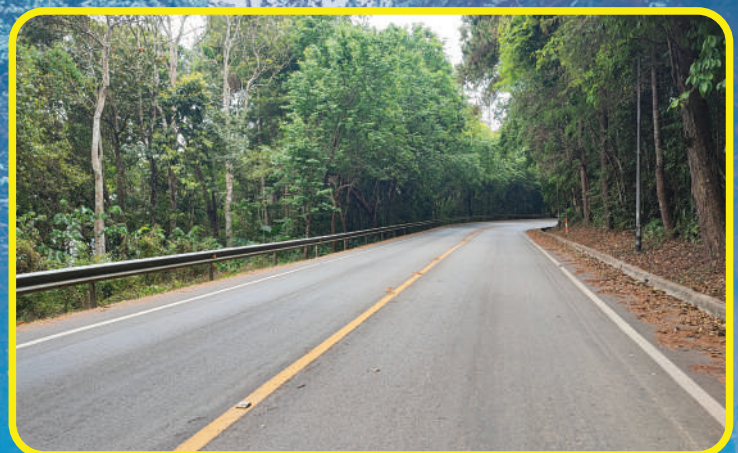
สภาพพื้นที่ทางหลวงหมายเลข 1004 (ขนาด 2 ช่องจราจร)
