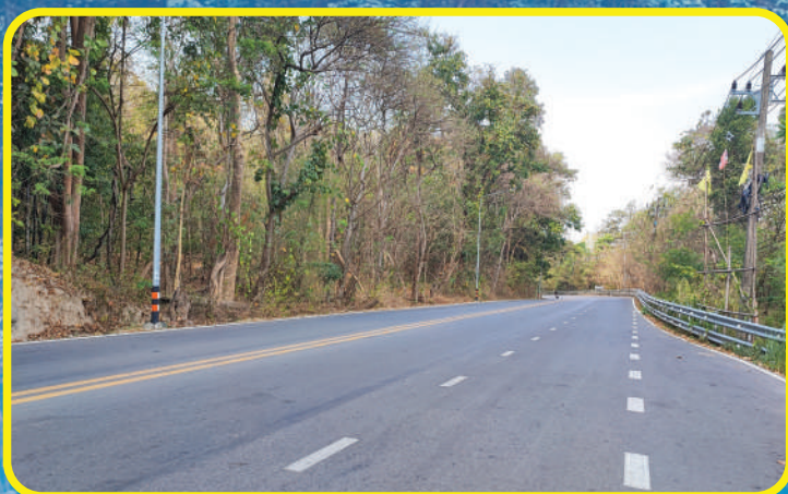
สภาพพื้นที่ทางหลวงหมายเลข 1004 (ขนาด 3 ช่องจราจร)
